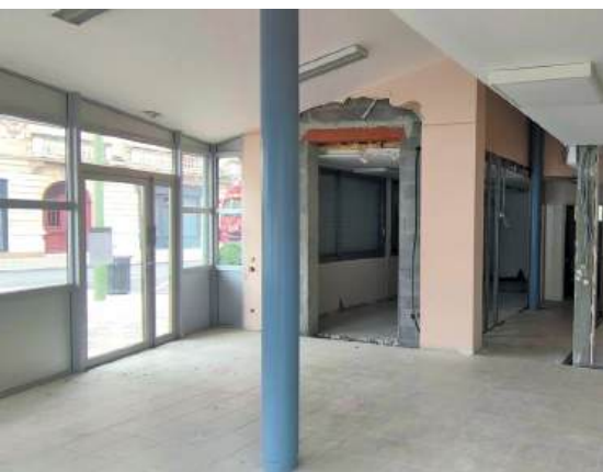
Travaux du cabinet de kinésithérapie
