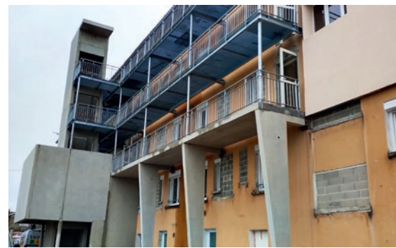
Travaux d'accessibilité à l'arrière du bâtiment
