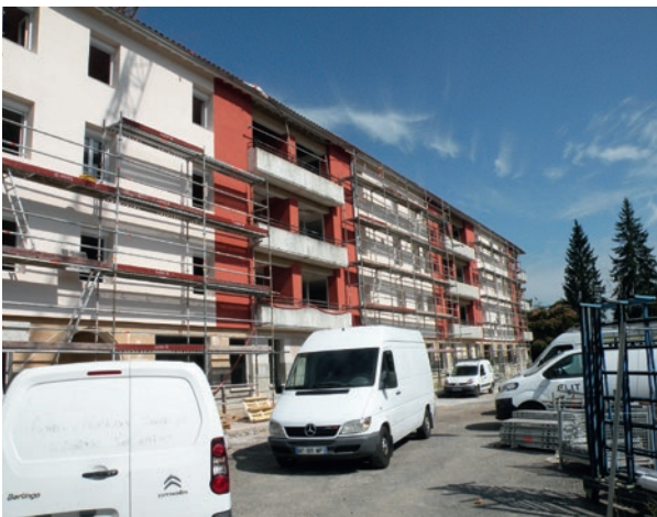
Pose du crépis sur la façade avant
